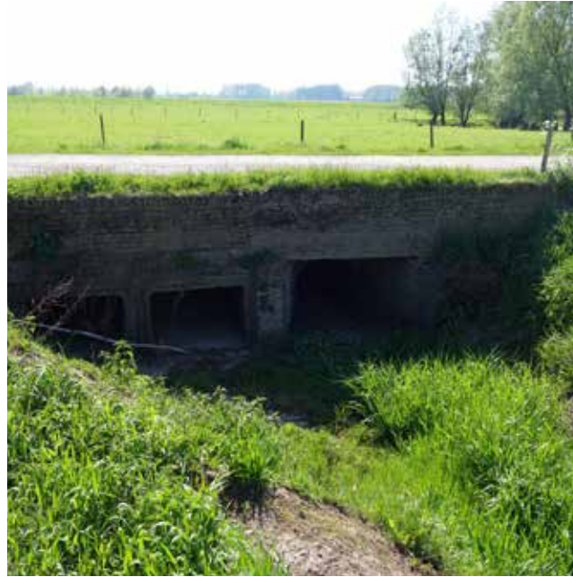
Figuur 25: Bestaande duikers onder de toegangsweg.
