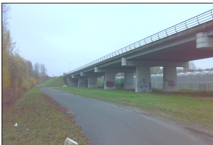
Figuur 5: Brug van ProRail bij de Bouwlustlaan in Bemmel
