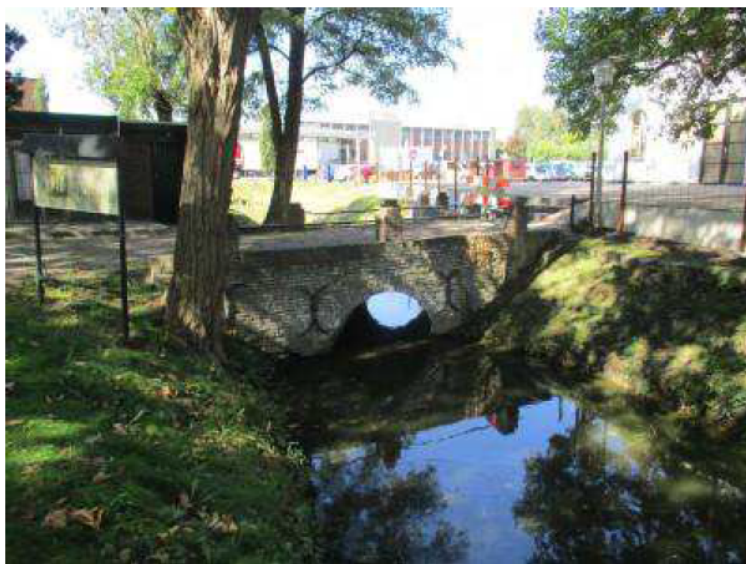
Figuur 5: Metselwerkbrug aan de Kinkelenburglaan 4 te Bommel
