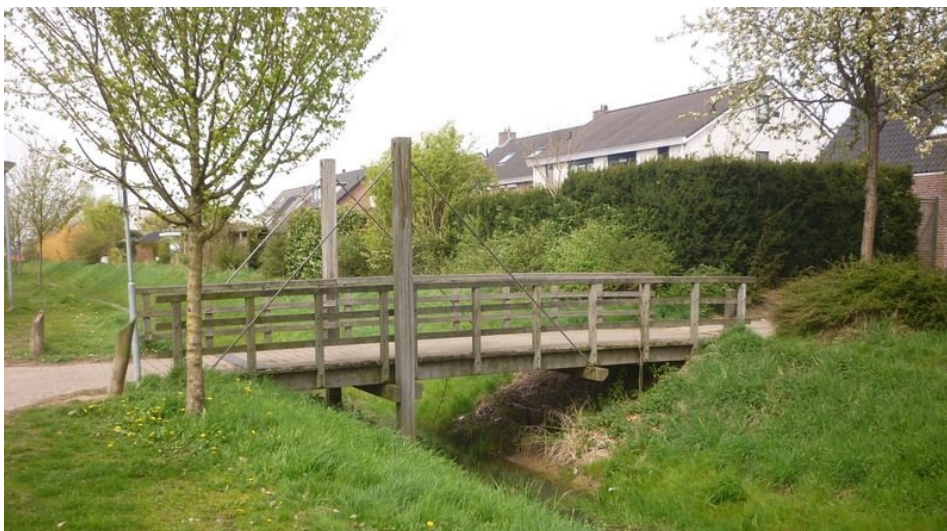
Figuur 4: Een houten brug (levensduur ca. 30 jaar)
