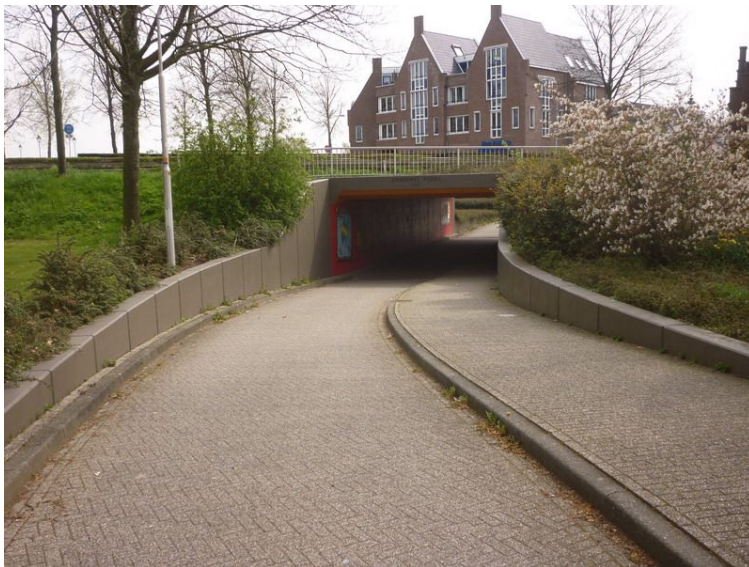
Figuur 1: Tunnel onder Stadswal te Huissen.
