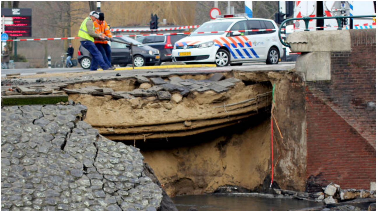
Figuur 6 Een ingestort stuk kademuur bij de Nassaukade in maart vorig jaar (Bron ANP)
