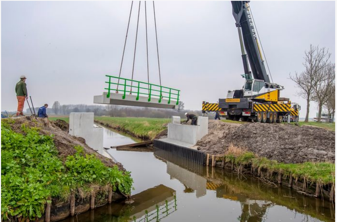
De nieuwe brug over de Gros werd in maart 2019 aangelegd. © Pix4Profs/Peter Braakmann
