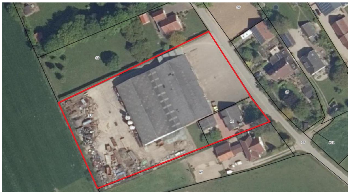
Afbeelding 2: Luchtfoto van het plangebied (bron: ruimtelijke plannen)
