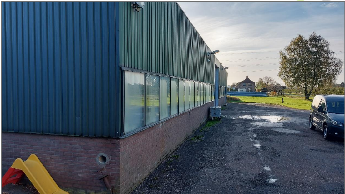
Westgevel van de bedrijfsschuur kijkende richting het zuiden. Foto: M. de Vries | Ecoresult B.V.
